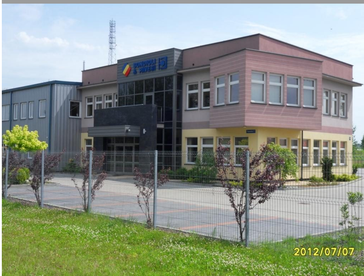
OBIEKT : Budynek biurowy z halą magazynową typ ASTRON (luty 2008r.)
